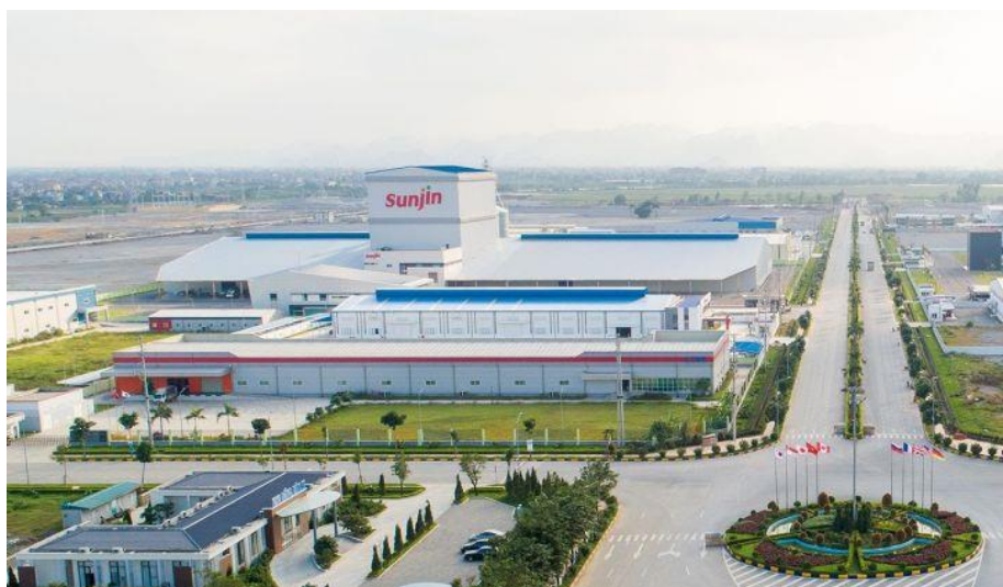
Khu Công nghiệp Châu Sơn, Phủ Lý
