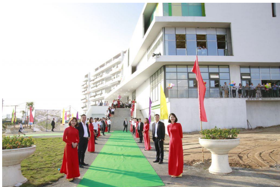
Bệnh viện Hữu nghị Việt Đức cơ sở 2 tại Phủ Lý, tỉnh Hà Nam khánh thành năm 2018
